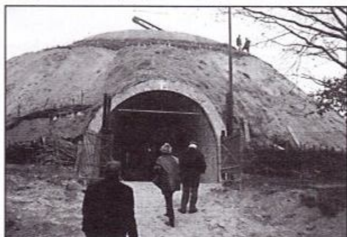
Na budowie Ośrodka Pamięci Zmarłych „Kurhan” w Karniowicach k. Trzebini. Średnica - 25 m; wysokość - 15 m (wraz z krzyżem na szczycie 28 m); grubość ścian - 30 cm; zbrojenie płyty fundamentowej - 120 ton stali; zbrojenie kopuły - 450 ton stali; przewidywana liczba krypt - 300; wymiary jednej krypty: 4 m x 2 m.
