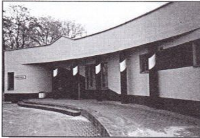
Budynek Administracji Cmentarza Komunalnego przy ul. Wojska Polskiego.
